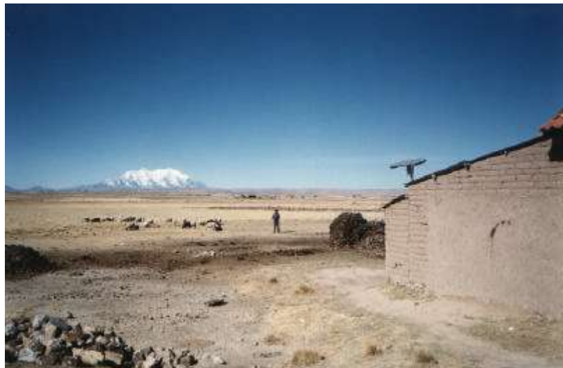
Figura 2.4. Moradia e sistema fotovoltaico no altiplano andino.
