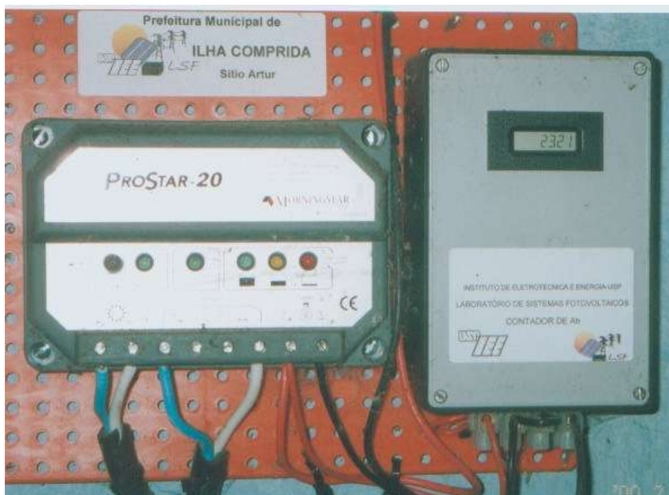
Figura 3.10. Vista de um medidor de Ah instalado em uma das moradias da comunidade de Sítio Artur.
