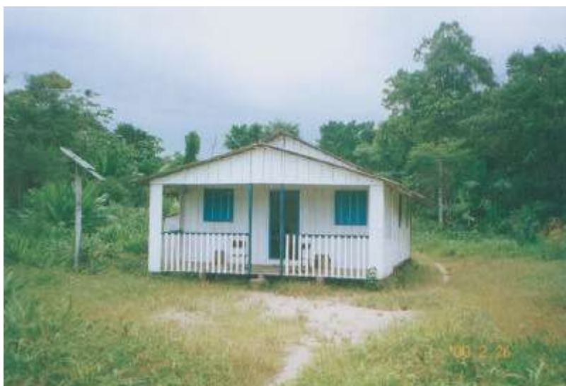
6.15. Escola de 1º grau da comunidade de Varadouro.
