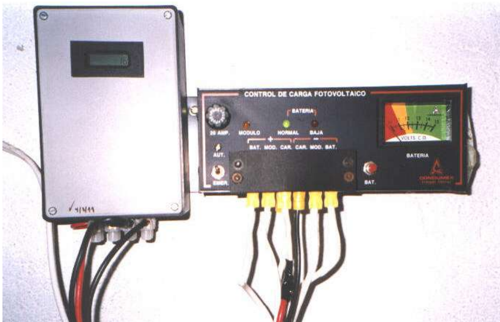
Figura 3.9. Vista de um medidor de Ah instalado em uma das moradias da comunidade de Marujá.
