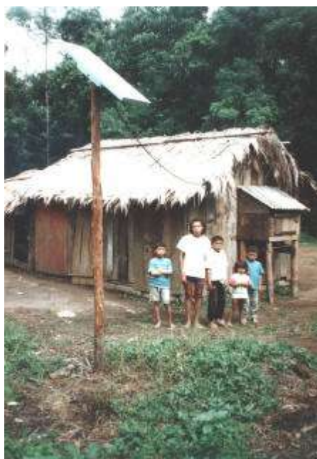
Figura 4.8. Moradia, família e gerador fotovoltaico da comunidade de Varadouro.
