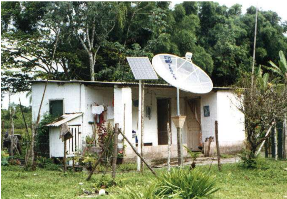
Figura 5.7. Moradia e gerador fotovoltaico da comunidade de Sítio Artur.
