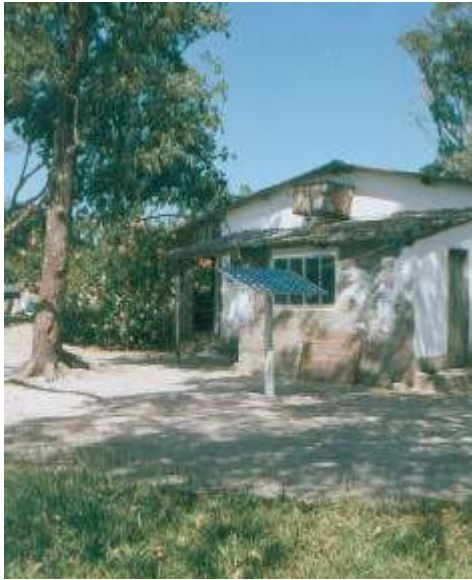
Figura 2.1. Instalação do programa ECOWATT com muito sombreamento.
