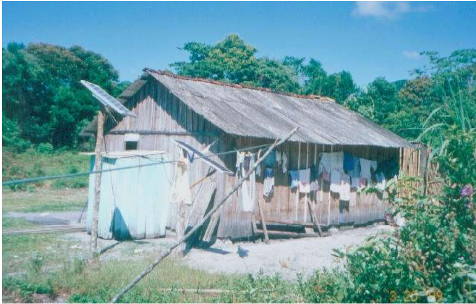
Figura 5.5. Moradia e gerador fotovoltaico da comunidade de Retiro.
