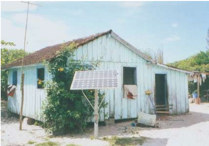
Figura 4.6. Instalação fotovoltaica do programa ECOWATT.
