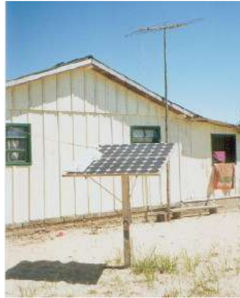
Figura 2.2. Instalação de programa ECOWATT onde por meio de um pano se reduz a geração elétrica.
