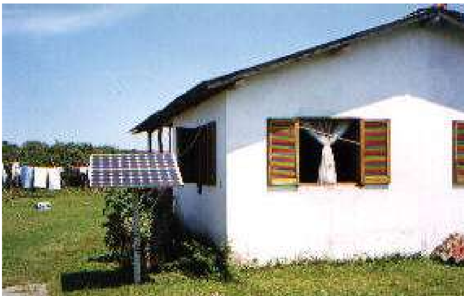
Figura 5.8. Moradia e gerador fotovoltaico da comunidade de Marujá.
